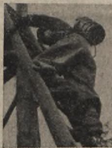
Rys. 6. Wejście na wieżę.
